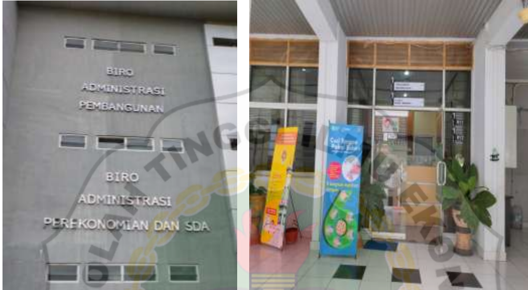
Gambar 3.1 Gedung Biro Administrasi Perencanaan SDA DIY
