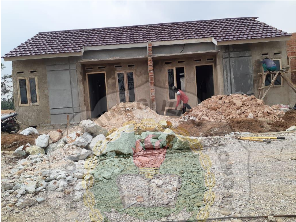
Lampiran 4. Progress 75% Pembangunan
