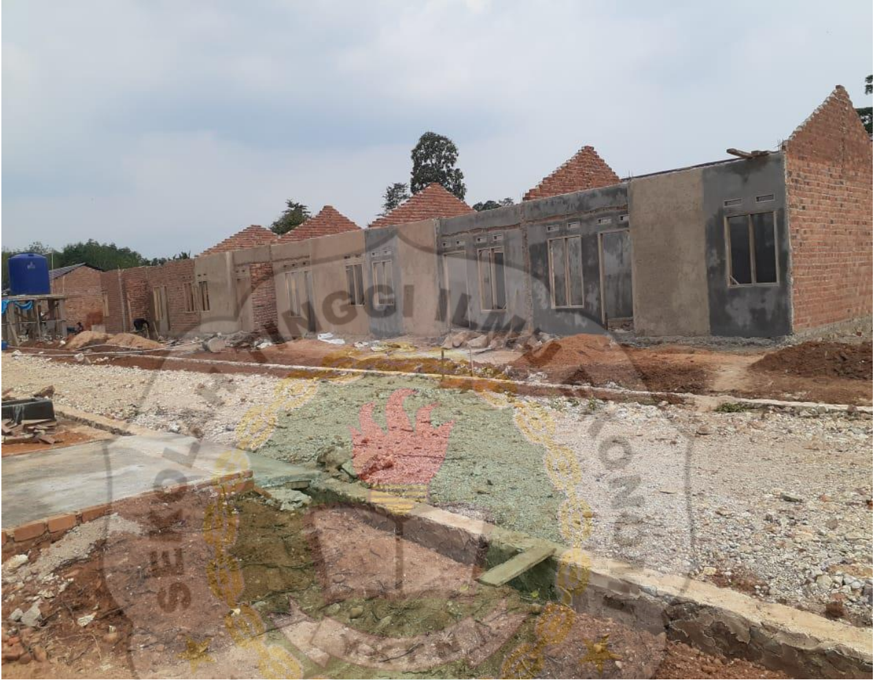
Lampiran 3. Progress 50% Pembangunan
