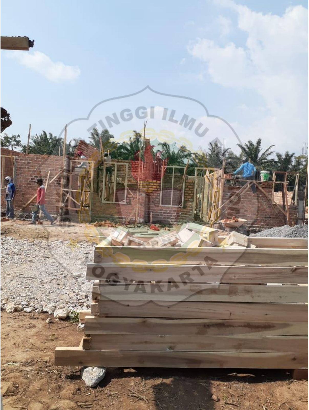
Lampiran 2. Progress 25% Pembangunan
