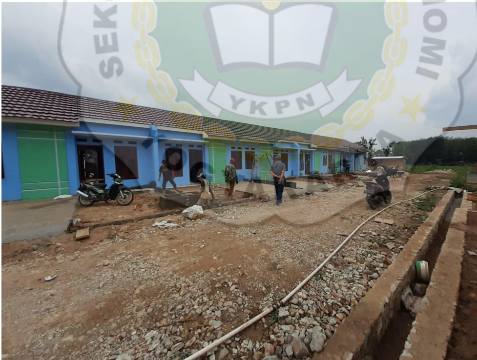
Gambar 3.2 Proyek Sedang Dikerjakan
